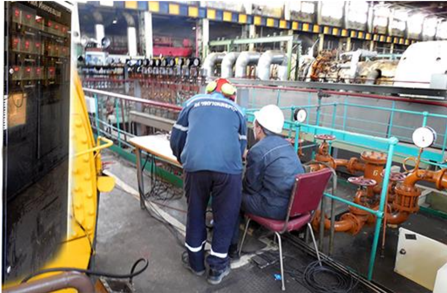
Рисунок 3 – Проведение расширенного виброобследования с использованием многоканального виброизмерительного комплекса UMS-16
